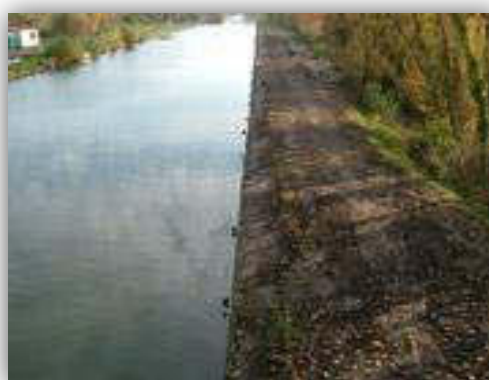
Exemple de confortement de berges sur un canal
