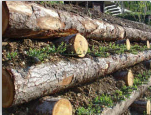
Rondins de bois résineux d'un caisson végétalisé
