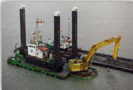
Opération de dragage mécanique sur eau
