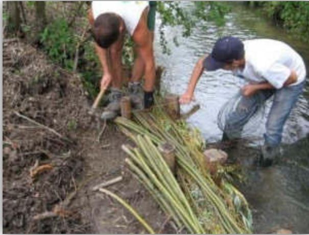
Mise en place de fascine de saule
