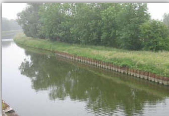
Rideau de palplanches en bordure de canal
