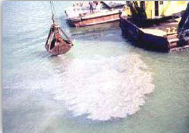
Panache turbide créé autour d'une benne preneuse en action
