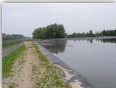
Casier étanche rempli avec des sédiments liquides
