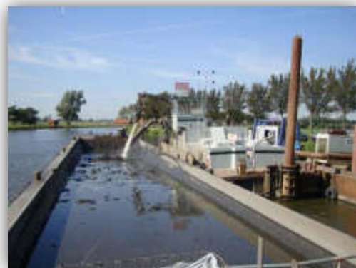
Remplissage d'une barge par dragage hydraulique
