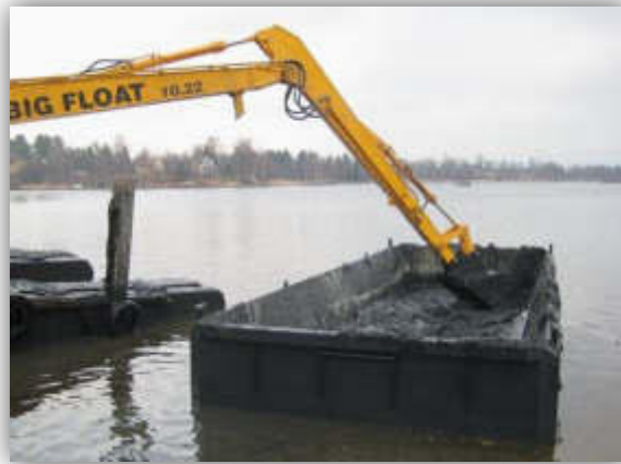
Mise à disposition de la barge à côté du lieu de dragage
