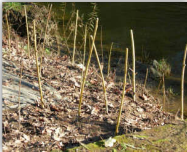
Pieux vivants plantés en bordure de berge
