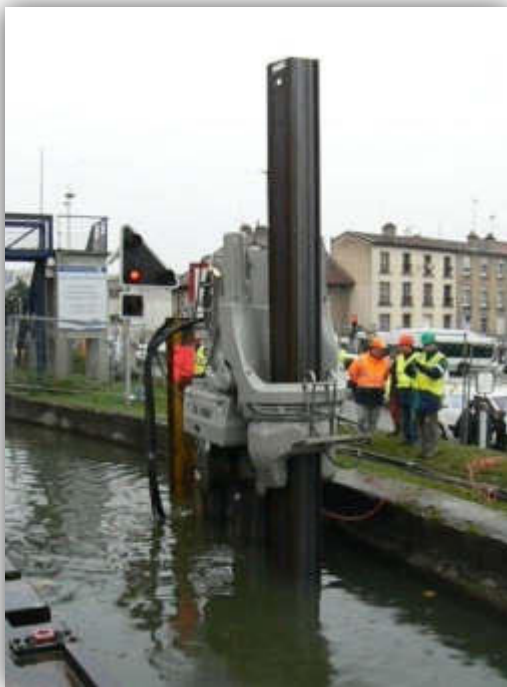
Confortement de la Digue Oberlin à Nancy avec un rideau de palplanches mis en place par verineur
