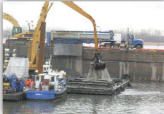
Transfert de sédiments d'une barge à un camion
