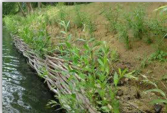
Remblai derrière un ouvrage de tressage, accompagné d'un géotextile
