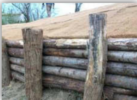
« Mur » formé par la technique de tunage
