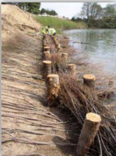
Mise en place des fascines entre les pieux
