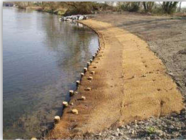
Géotextile déployé sur une berge
