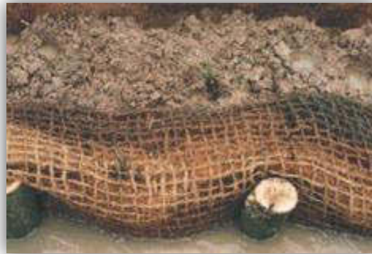
Détail de l'ouvrage après réalisation
