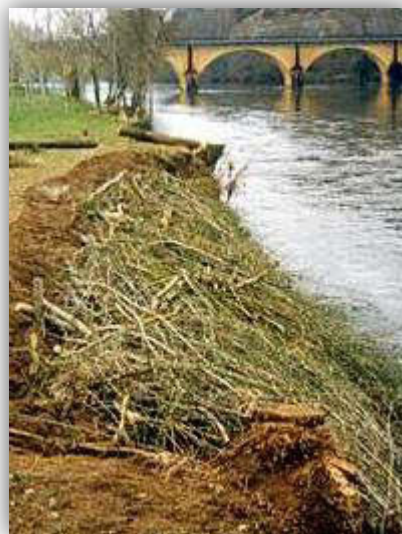
Anse d'érosion comblée par un peigne
