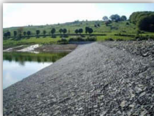
Matelas de gabions
