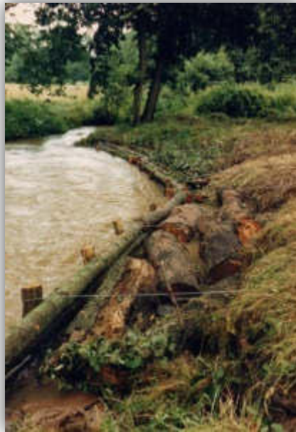
Protection de berge par tunage-peigne
