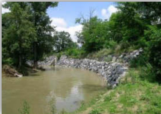
Enrochement protégeant la berge de l'érosion
