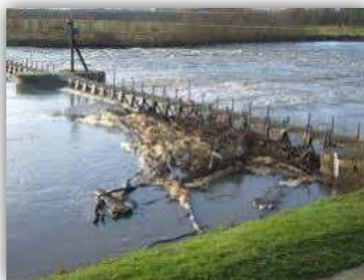
Accumulation de débris sur un seuil de rivière formant un embâcle
