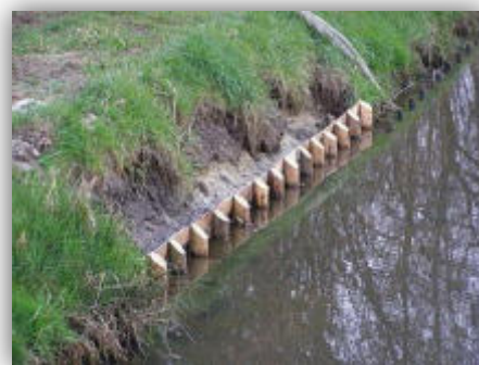
Protection de berge par tunage, sans végétation
