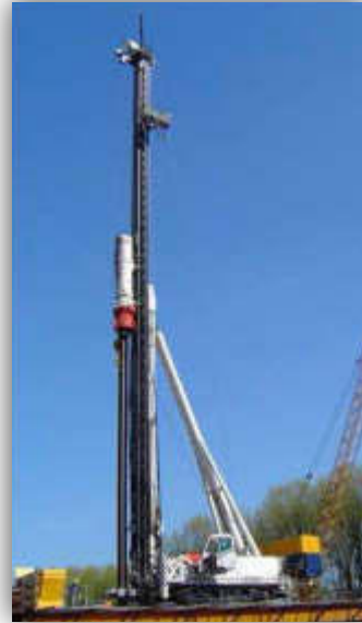
Opération de battage
