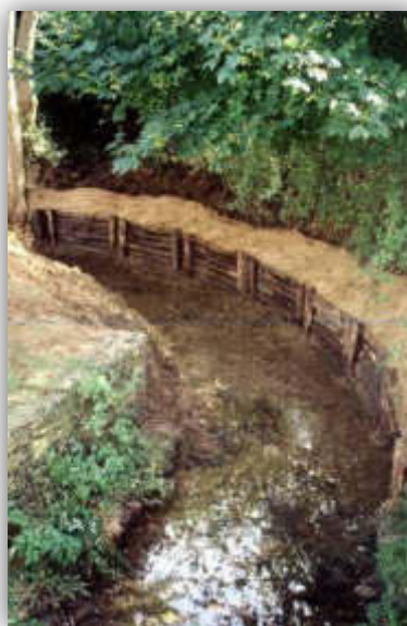
Protection de berges d'un petit cours d'eau par tunage
