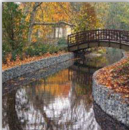
Rives formées par des gabions
