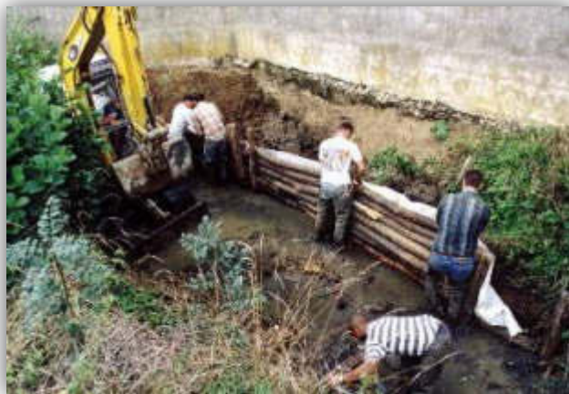
Mise en place d'un géotextile
