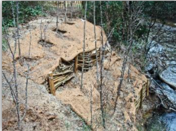
Protection de berge par plantation en escalier
