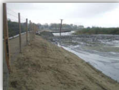
Casier non étanche en cours de remplissage avec des sédiments vaseux
