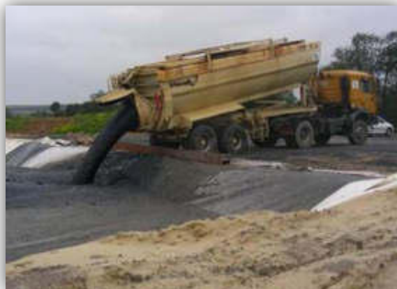
Déchargement de sédiments dragués sur un site de dépôt après transport par camion étanche
