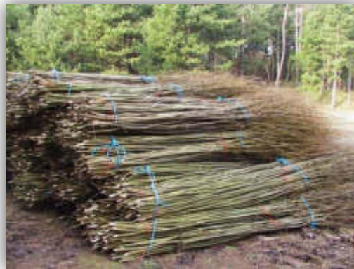
Fascines de saules confectionnées avant installation
