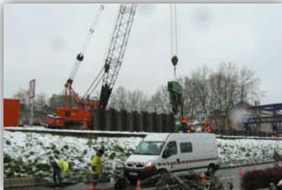
Confortement de la Digue Oberlin à Nancy avec un rideau de palplanches mis en place par vibrofonçage
