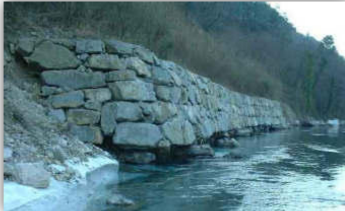
Mur d'enrochement
