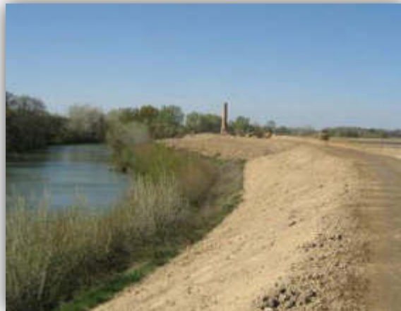
Berge protégée par un corroi
