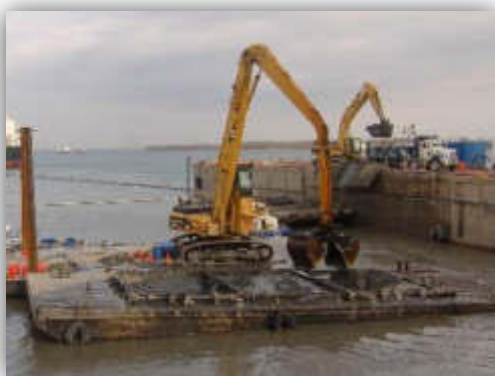
Barge utilisée lors d'un dragage mécanique
