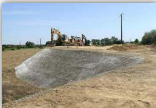
Travaux de corroyage
