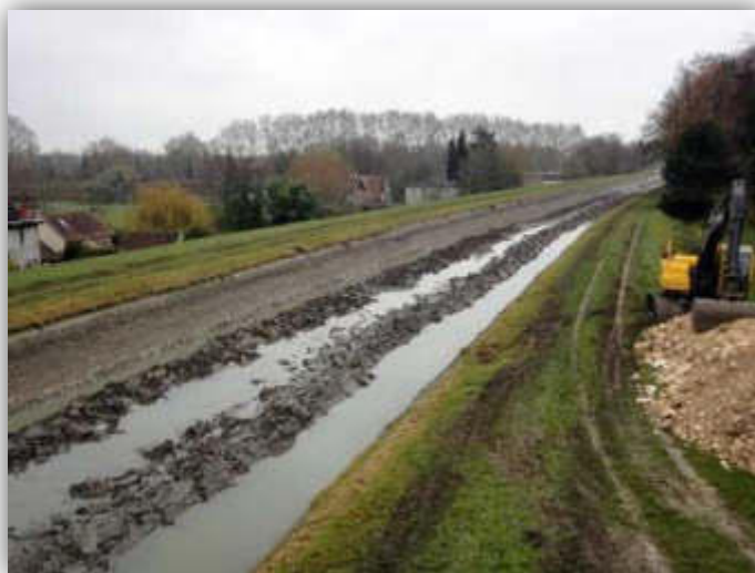
Opération de dragage mécanique à sec
