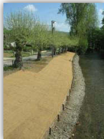
Sol recouvert d'un film coco en arrière de la barrière de tunage
