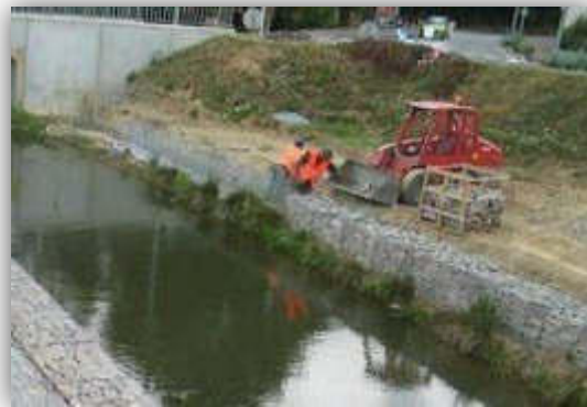
Remplissage manuel de gabions en bordure de rive
