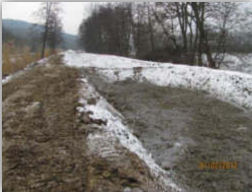
Renforcement de berge avec la création de casiers
