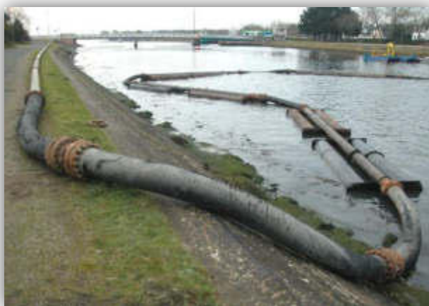
Canalisations flottantes pour le refoulement des sédiments
