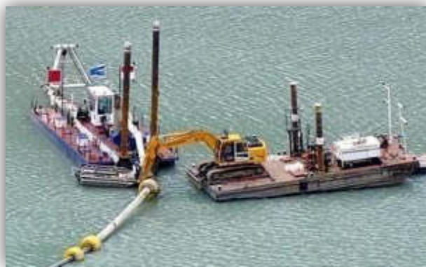
Atelier de dragage hydraulique avec refoulement par conduite flottante
