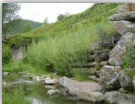
Repousse dans un caisson végétalisé
